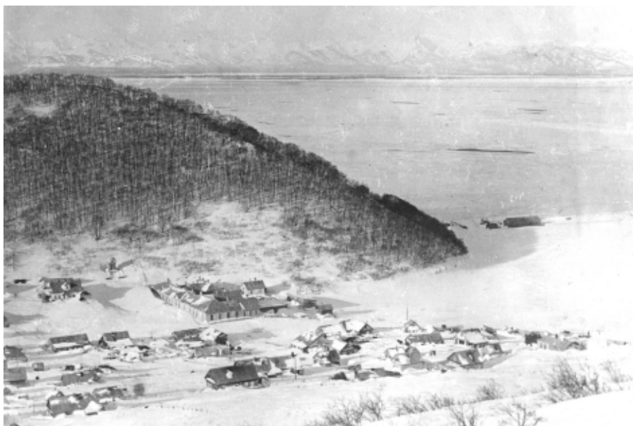
Рис. 8. Южный берег озера и примыкающая к нему часть городской застройки, 1922 г. (из фондов ККОМ)
